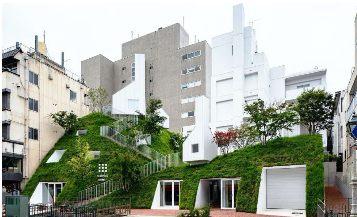
グリーンタワー外観 photo: Shinya Kigure
